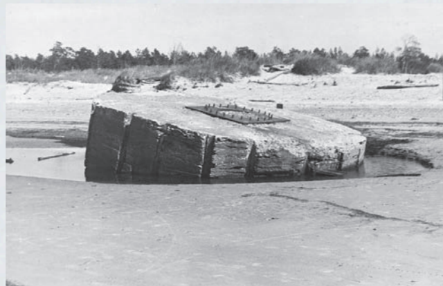
▲ Фундамент под орудия батареи на острове Ягры. 1987 год. В годы войны на таких основаниях располагались 152-мм орудия системы КАНЭ
